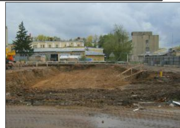
Площадка после демонтажа корпуса Б на сентябрь 2015 года
