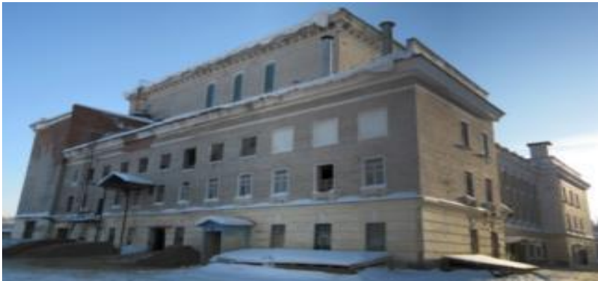
Внешний вид здания ПУГР ЭИ-2 до начала работ по ВЭ
