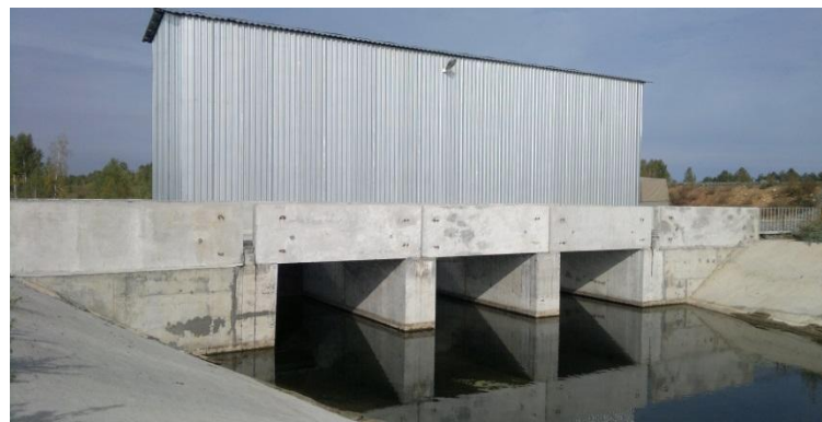
Созданы пороги-регуляторы для исключения попадания загрязнённой воды в открытую гидросеть
