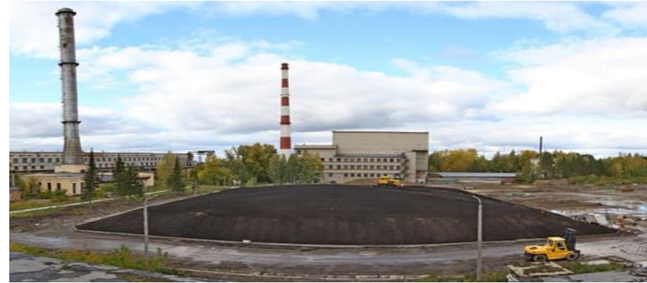
Пункт консервации особых РАО на момент завершения работ по ВЭ ПУГР ЭИ-2
