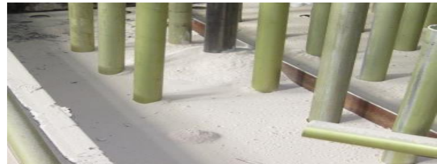
Засыпка барьерным материалом
